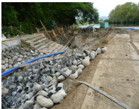
鞍掛堰右岸の工事現場（H28年4月末 段階）
