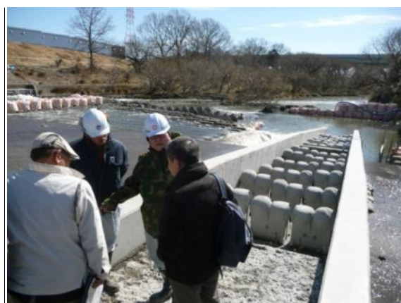
出丸堰魚道（川島町）の現場検討・意見交換会（3/2）
