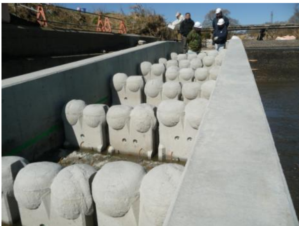
はつらつプロジェクト魚道現地検討会（3/2） 越辺川出丸堰魚道整備現場にて
