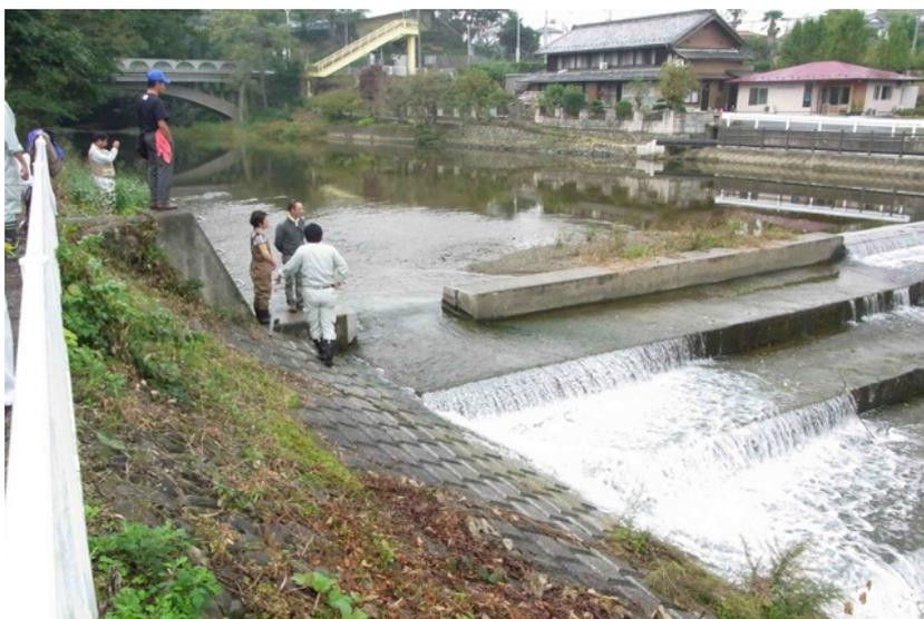
写真 1 宮ヶ谷戸前堰の確認（右岸側に増設された通水路は 2 枚の堰板で調整できる）
