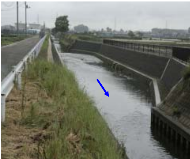
狭山市草刈橋付近の新河岸川水系不老川。 部分的に拡幅し、低水護岸している。
