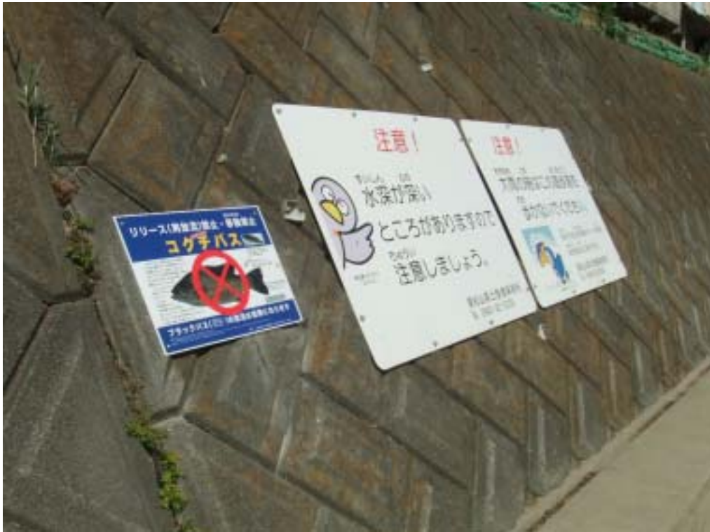
遊歩道より約 1.5mの高さに、アンカー・プラグ・ビス止め。
