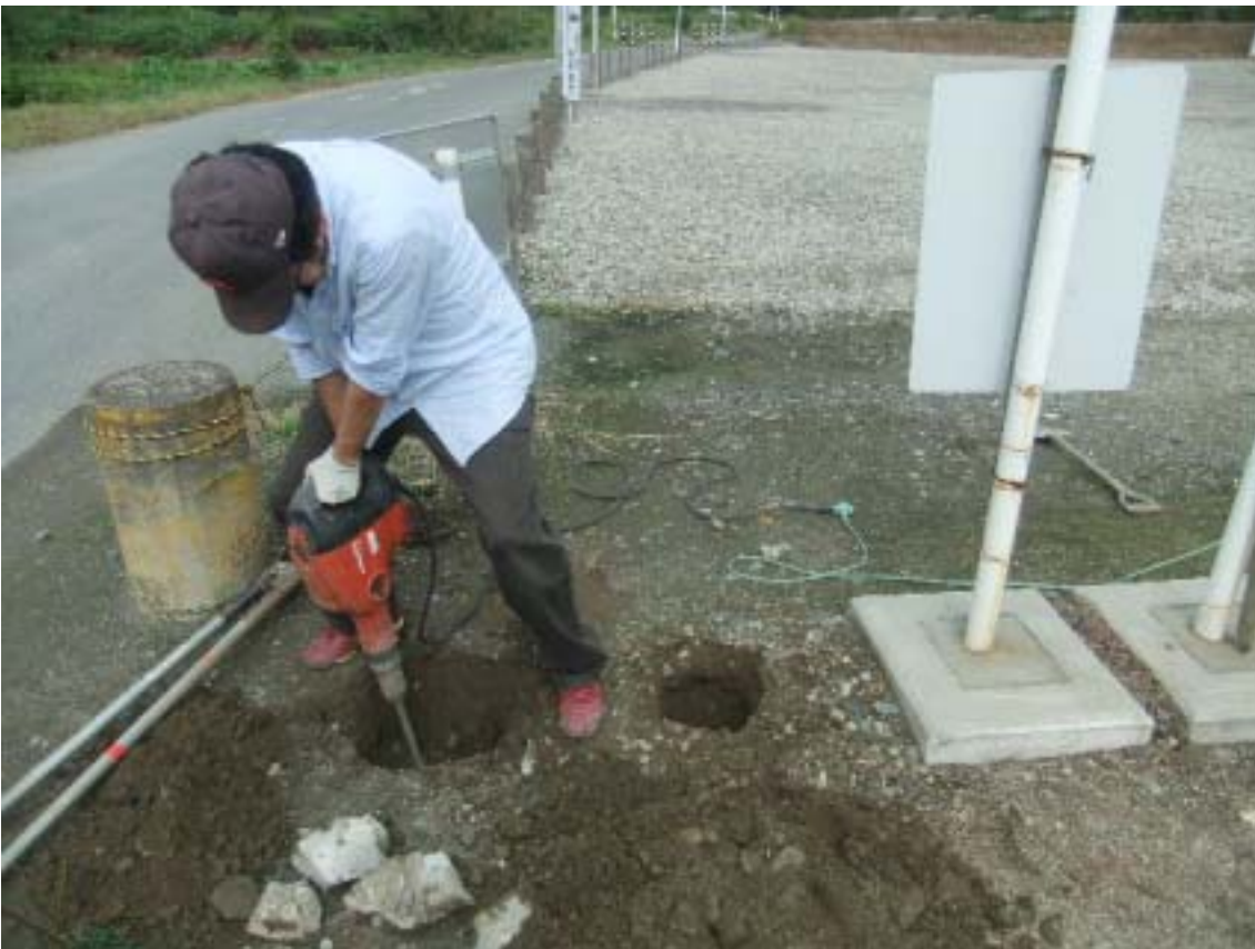
写真-2. コクチバス周知ボード(鉄骨2本脚構造)の基礎工事。
