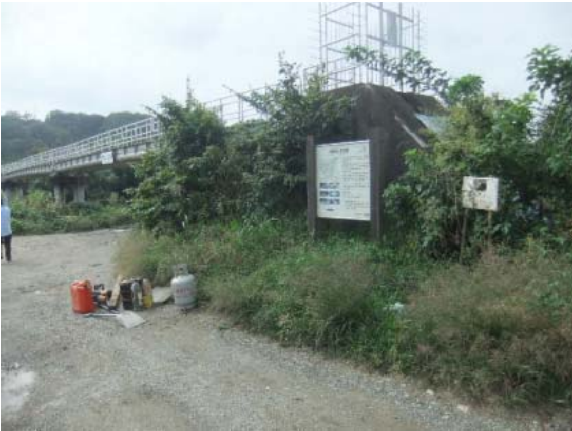
写真- 5 . 稻荷橋（通称 = おとうか橋）左岸水管橋付近の現存するボード全景。
