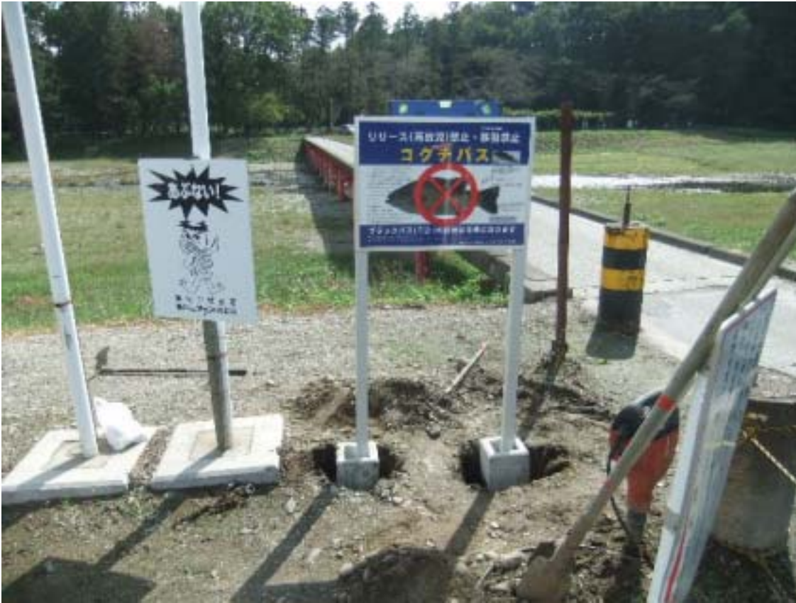
写真- 3 . A - 2 版 ( 700mm × 500mm ) 周知・啓発ボード ( 2 本脚 ) の設置工事。
