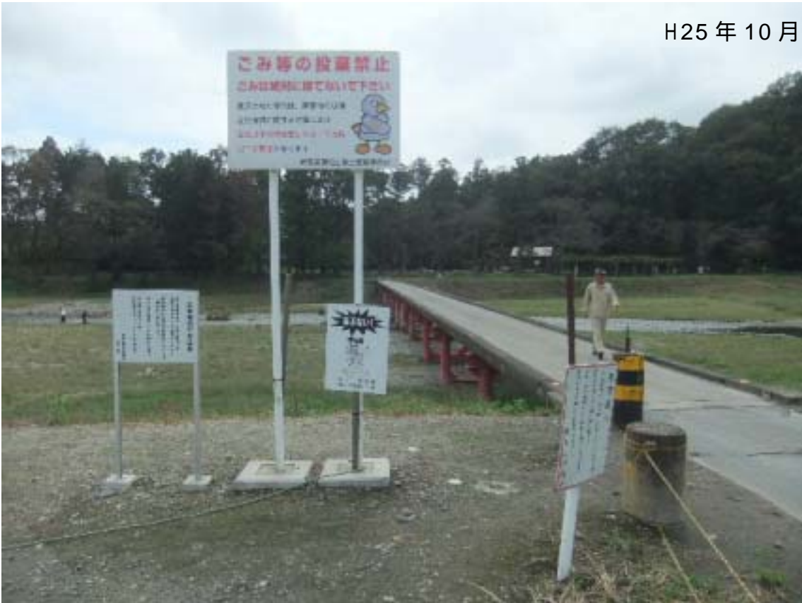
写真-1. 鞍掛橋左岸たもとの、現存するボード群全景 (H25.10.7 午前)
