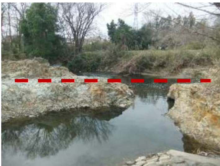
A地区新川の 基盤岩の堰 (洗掘による低下)
