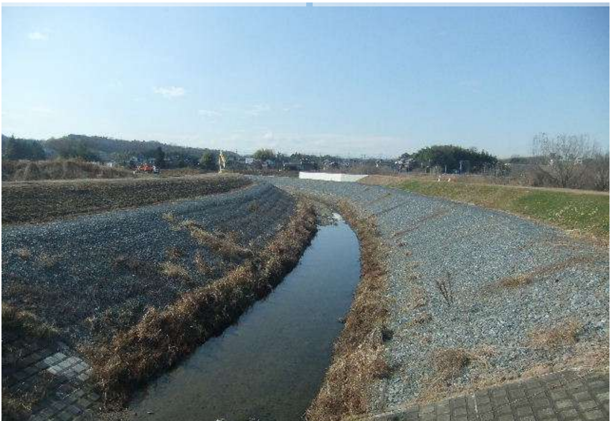
和田川：国道 407 号下流 500m 付近。定規断面による、蛇籠護岸。一部コンクリート擁壁の嵩上げ。
