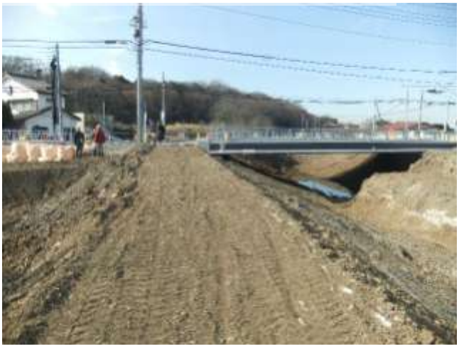
吉野川：国道 407 号下流 50m 付近。河床掘削・築堤
