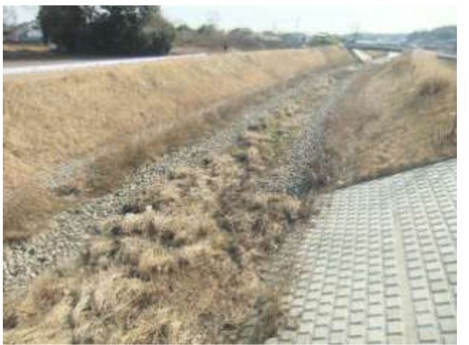
吉野川：国道下流 200m 付近。玉石河床。蛇籠護岸
