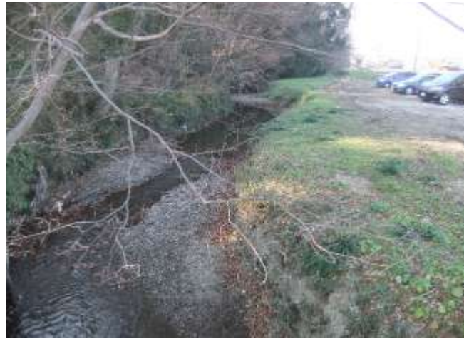
吉野川：国道上流 200m 付近。蛇行河川。
