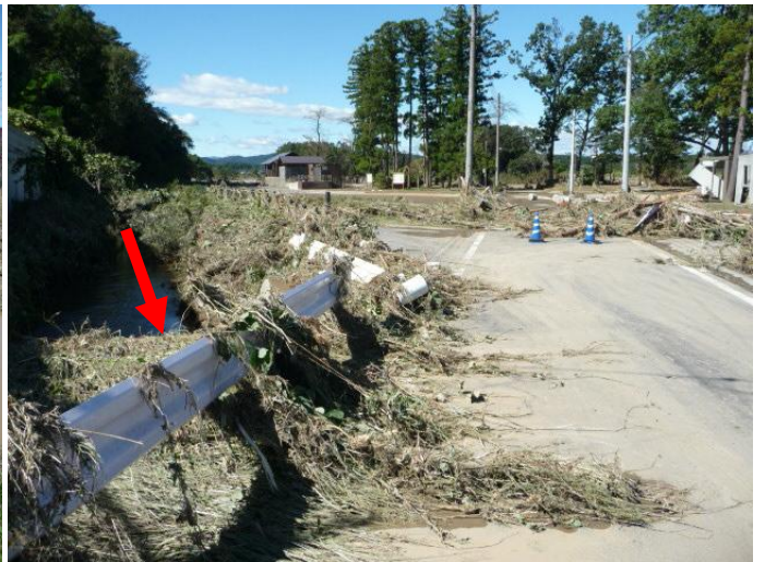
■神戸用水路は、氾濫で完全に破損。魚類の死骸が多い。通行不可の「立て看板」あり。遠方は、トイレ・四阿。
