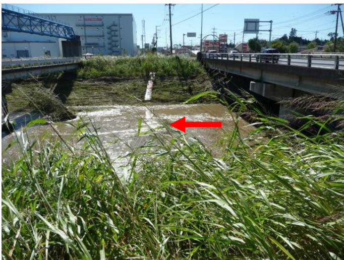
■市野川と交差する国道 407 号天神橋交差点。 右岸には斜めの水位標。兩岸とも越流の痕跡なし。
