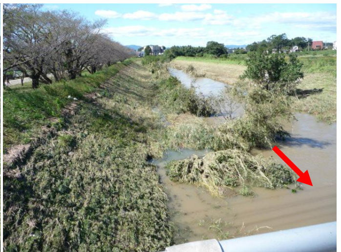
■天神橋より上流の市野川の河況 (10:30 頃)。 越流の痕跡無し。堤防端場から余裕高約 1.4m。
