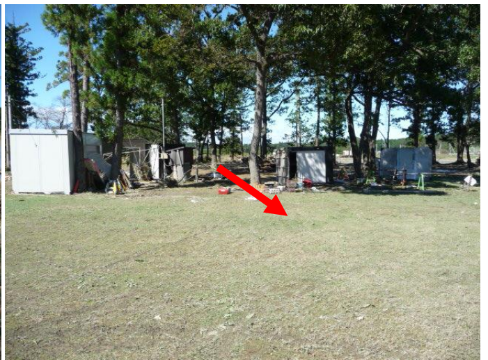
■左岸樹林帯の東松山市観光協会「BBQ施設」は壊滅。協会事務所のBOXは、下流へ約80m流されている。
