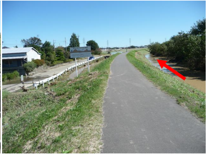
■矢来堰魚道設置個所の堰を見たかったが危険と判断。都幾川左岸堤防の内堤と外堤（洪水が発生中）11時。
