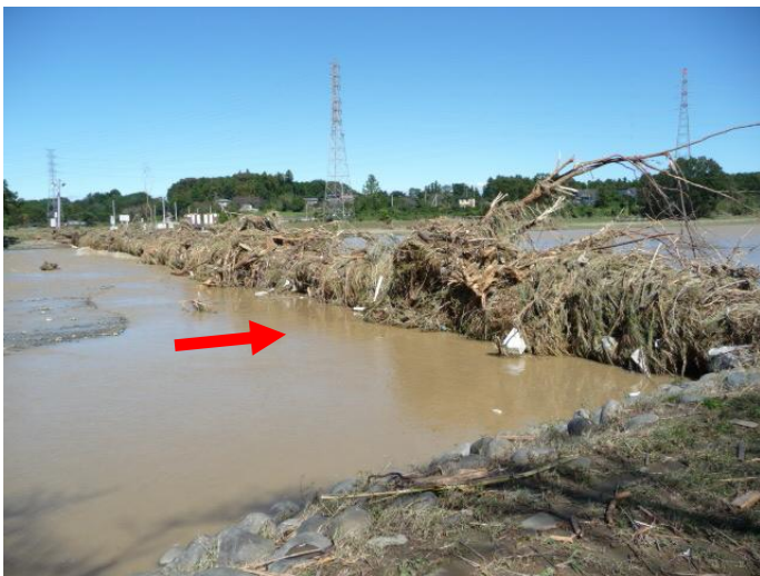
■鞍掛橋（冠水橋）に留まった流木群（高さ約2m）。四阿横の藤棚は破壊され姿を消した（11時30分）。下流の「稻荷橋（冠水橋）」も同様の流木群あり。
