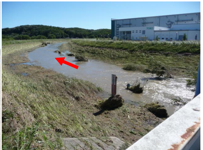
■天神橋水位観測地点 (10:25 頃)。余裕高約 1.4m。 区画整理で約 5m 右岸堤防を拡張した効果、抜群！！
