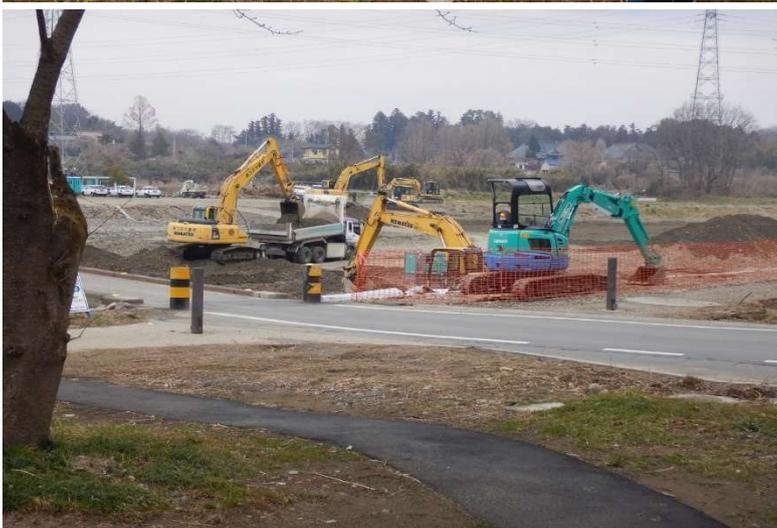
県の「川のまるごと再生プロジェクト」によって創られた「くらかけ清流の郷」は、大量の流出土砂が河道内に残り、県土整備事務所の発注により、多くの重機が投入されて、復旧工事で掘削・撤去が行なわれていました。
