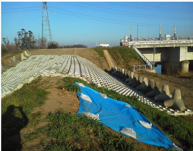
2箇所の決壊は、前ページの社叢を残す小剣神社付近(都幾川右岸、L=90m)と県管理区間の九十九川と(越辺川左岸、L=40m)です。両方とも、洪水による河川水位が計画高水位を超過して、暫定堤防区間で決壊・越水を起こし、浸水範囲を広げたものとの説明があった。
