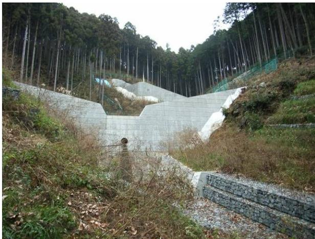
整備された砂防堰堤(ときがわ町後野川)
