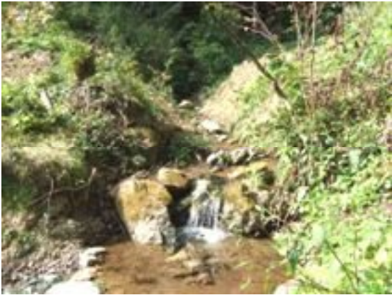
上流えん堤よりも上流域(工事対象外)に土石が堆積する溪流の様子
