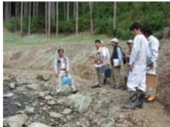
整備終了した上部えん堤の下流側で、整備事務所からの説明を聞く参加者。 現地にあった大きめの石(玉石)を溪流の中に配置し、できるだけ自然に近い形に整備してある。
