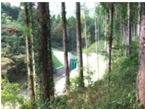
完成した上流えん堤(下流側山腹の慈光寺登山道から望む)
