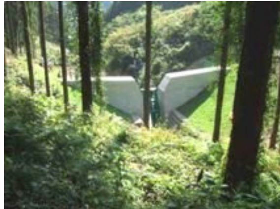
完成した上流えん堤(上流側山腹から望む)の全景
