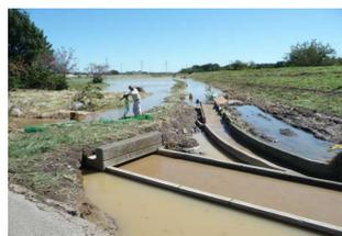
矢来堰（かごマットの堰）は一部分を残し崩壊。右岸低水護岸も破壊。
