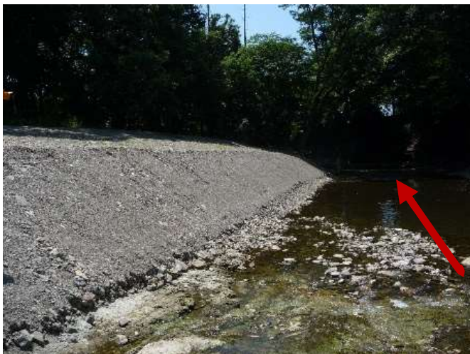
写真 4—3 枚 : C 地区直線河川呑口ボトルユニット工法 3 段 幅 6.4m 高さ 1.4m。蛇行河川護岸補修と河川幅約 4~5m、河床は一律掘削のため多自然型は見られず
