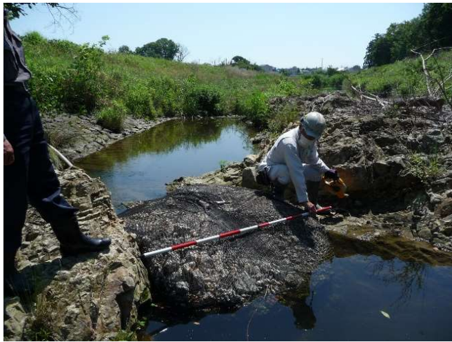
写真 1—3 枚:A 地区直線河川呑口ボトルユニット工法 2 段 幅 2m 深さ 1.6m。蛇行河川への維持流量は、順調に確保されている。
