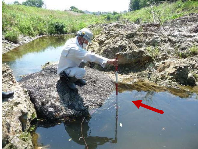
写真 1—3 枚:A 地区直線河川呑口ボトルユニット工法 2 段 幅 2m 深さ 1.6m。蛇行河川への維持流量は、順調に確保されている。
