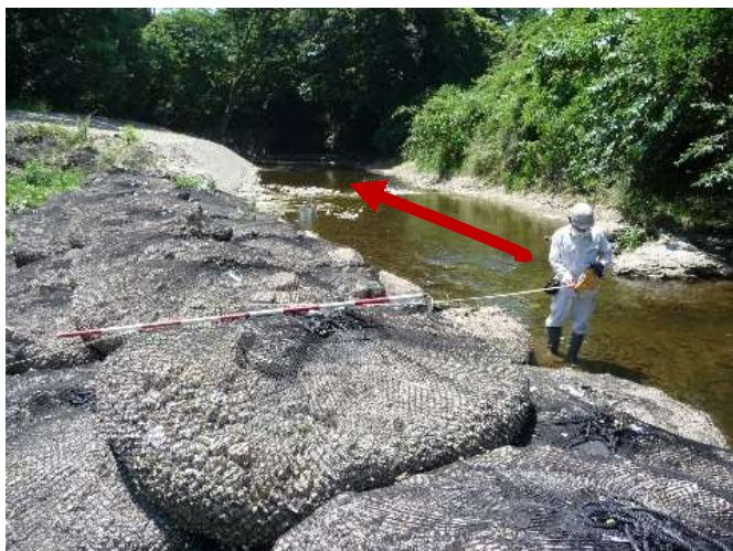
写真 4—3 枚 : C 地区直線河川呑口ボトルユニット工法 3 段 幅 6.4m 高さ 1.4m。蛇行河川護岸補修と河川幅約 4~5m、河床は一律掘削のため多自然型は見られず
