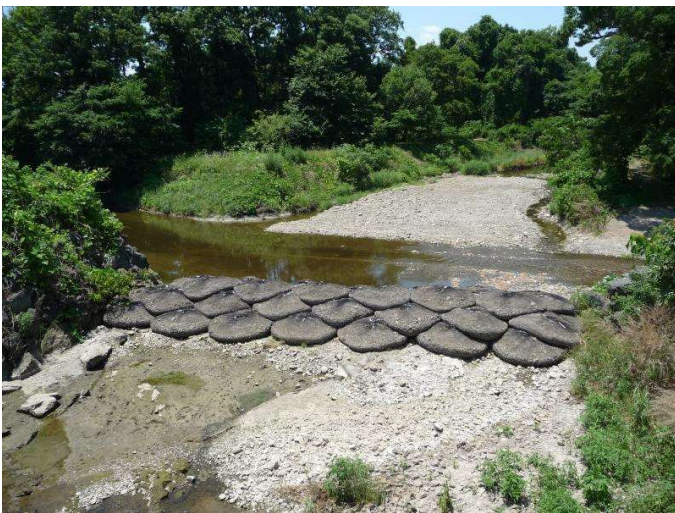
羽尾地区B区間 新川の堰嵩上げと、蛇行部河川の土砂浚渫(流下能力回復)
