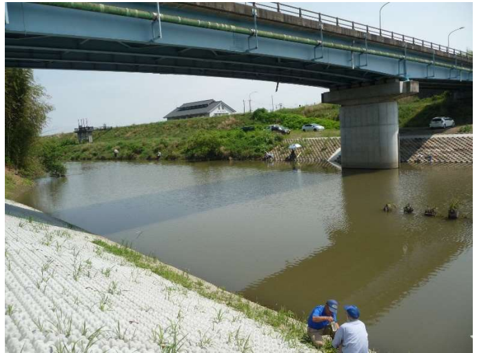
◆市野川慈雲寺橋下流 (In12) の採水作業。
